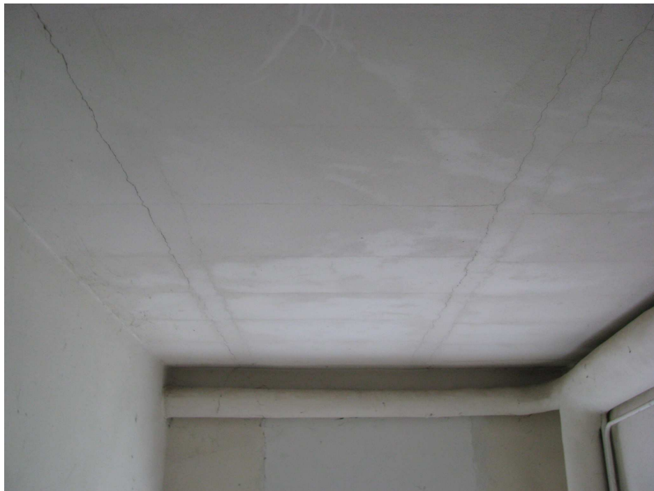
FOT. 2. Charakterystyczne "klawiszowanie" stropu WPS
